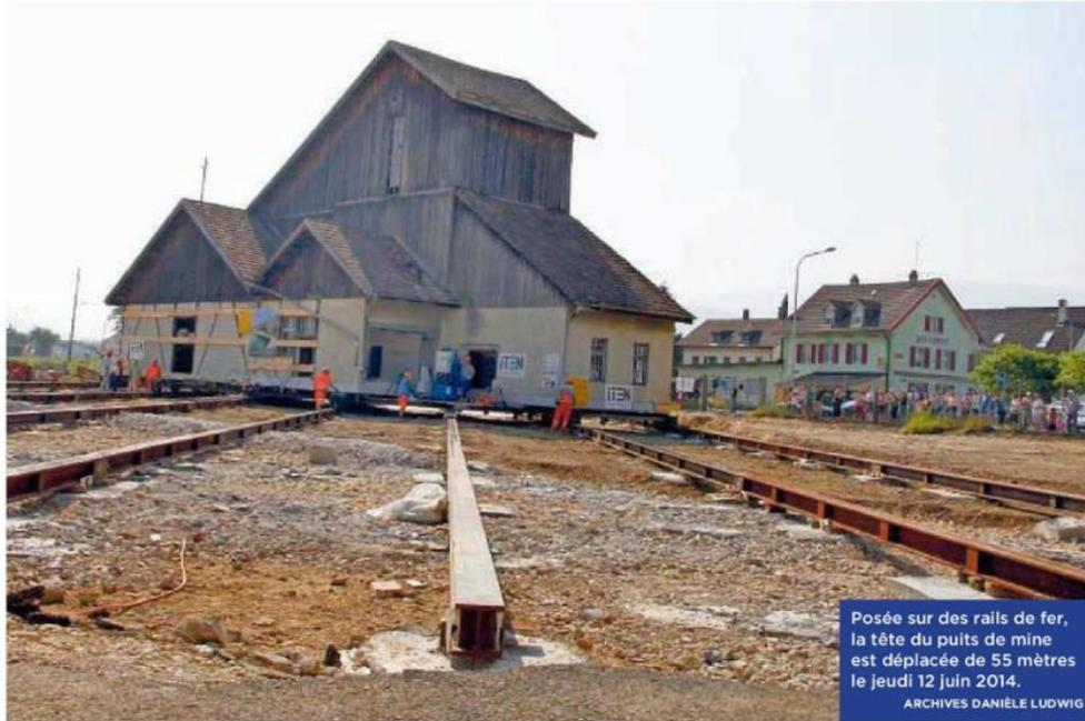
Posée sur des rails de fer, la tête du puits de mine est déplacée de 55 mètres le jeudi 12 juin 2014.
